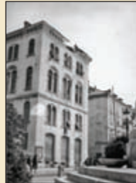
Oštećena zgrada Narodne banke u Splitu
